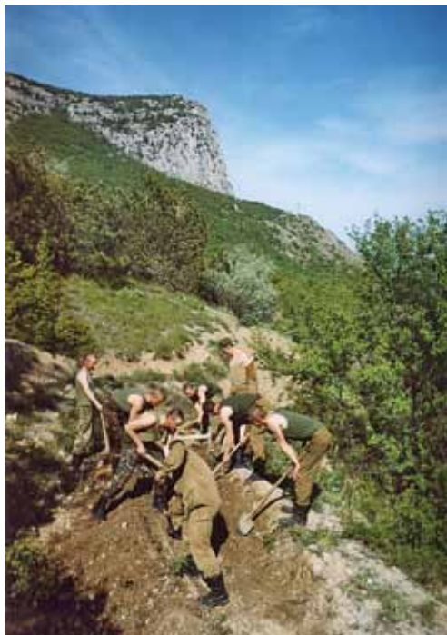
Прокладка кабелю у Кримських горах.
