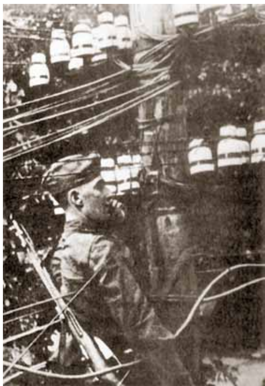
Вимірювання параметрів постійної повітряної лінії зв'язку.
