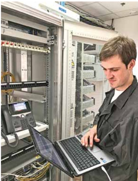
Налагодження обладнання IP-телефонії.
