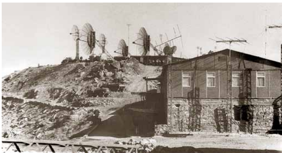
Кабул, технічна будівля кінцевого тропосферного пункту.
