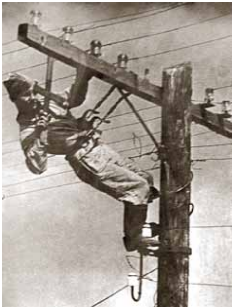
Монтаж повітряної лінії зв'язку.
